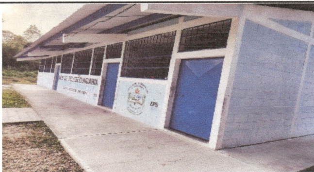
foto 5, pintura en muros exteriores e interiores
