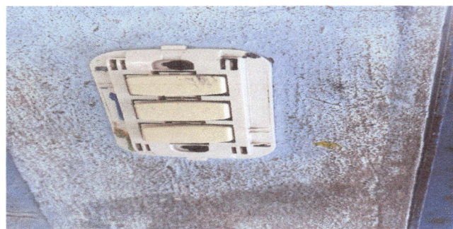
foto 10. sustitucion de interruptores dobles
