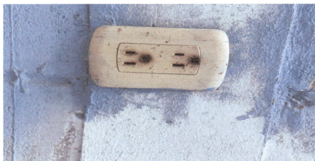
foto 11. sustitucion de tomacorrientes dobles
