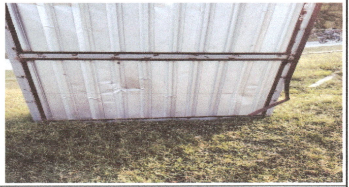
foto 2. sustitucion de porton de metal
