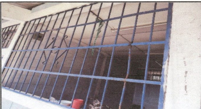
foto 3. mantenimiento a portones de metal
