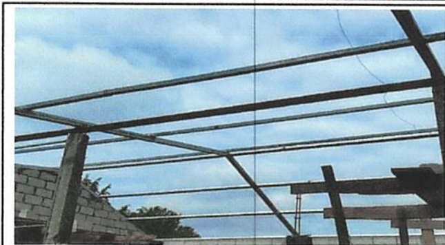
Foto 1: En esta imagen se observa la finalización del cambio de la estructura de metal.
