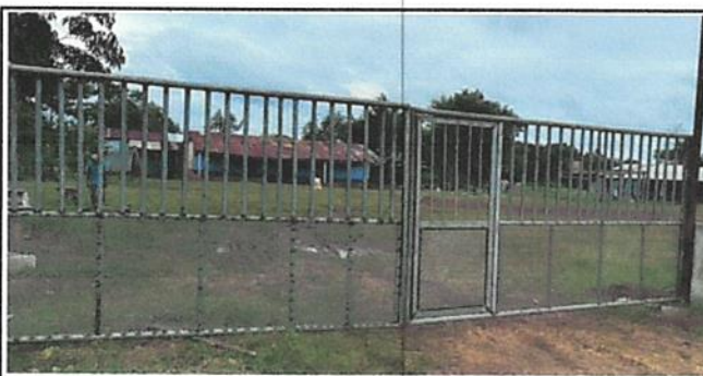
Foto 5: En esta imagen se observan la susitución del porton de metal.
