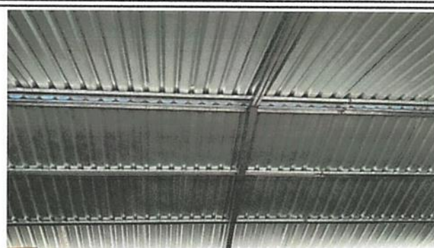
Foto 2: En esta imagen se observa la finalización de la sustitución de la lamina.
