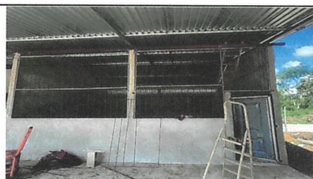
Foto 4: En esta imagen se observa la finalización de la sustitución de los balcones de metal y la puerta de metal.
