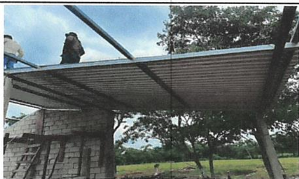
Foto 3: Se observa como el padre de familia y el encargado de la obra estan realizando el cambio de la lámina.
