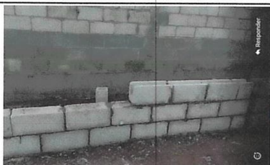
Foto 5: En esta imagen se observan las hiladas de block que se colocaron en el area perimetral.
