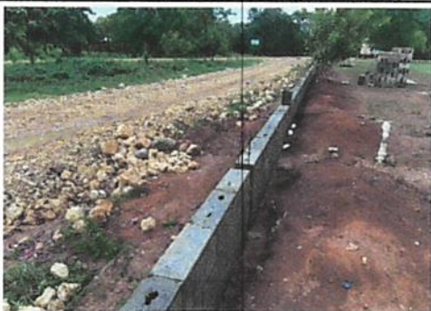
Foto 1: En esta imagen se observa el avance del área perimetral que se trabajo en la escuela.
