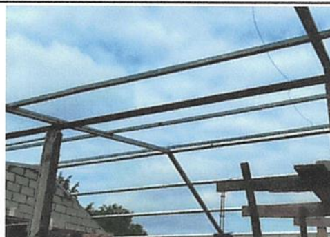
Foto 2: Se observa el avance de la estructura de metal.
