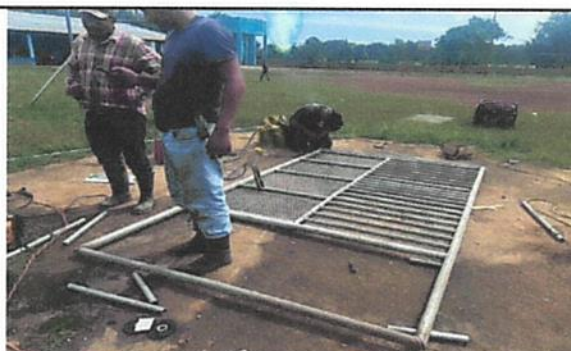
Foto 4: En esta imagen se observa como se esta realizando el porton principal de la escuela.
