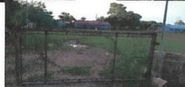
Foto 6: Muro perimetral y se va a sustituir el porton.
