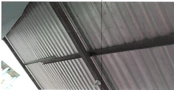
Foto 1: cubierta de lamina
