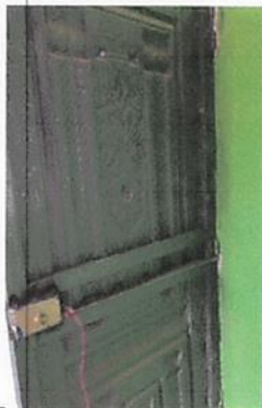
Foto 3: Puertas de Metal: Las puertas se dañaron de las soldaduras y ya no son seguras tambien hay que hacerles cambios de chapas
