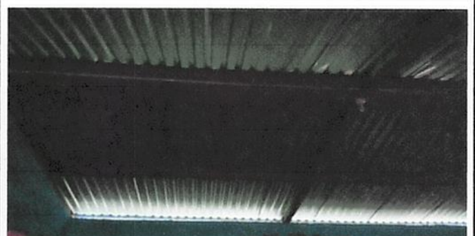
Foto 2: Estructura de techo: la estructura de esta aula se desprendio de las tijeras y necesitan cambiarlas aparte que las laminas tienen muchas goteras y hay que cambiarlas
