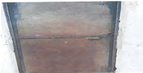
FOTO 3. SUSTITUCION DE CHAPA
