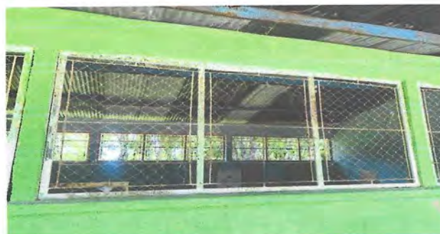
FOTO 4. SUSTITUCION DE BALCONES DE METAL
