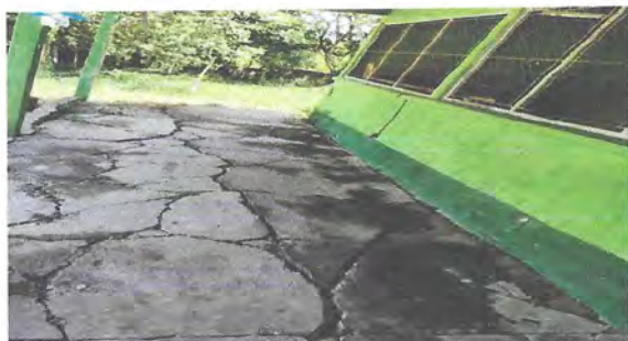
FOTO 5. SUSTITUCION DE TORTA DE CONCRETO
