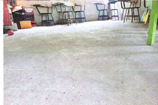
Foto 4: Sustrución de piso de cemento liquido
