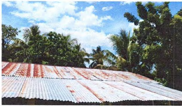
Foto 1: Sustrución de lámina, por lámina troquelada aluzinc calibre 26
