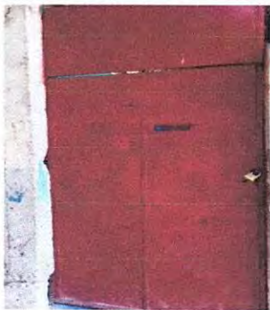
Foto 3: Sustrución de puertas
