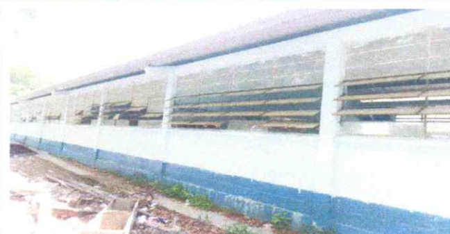
FOTO 4. PINTURA EN MUROS EXTERIORES E INTERIORES
