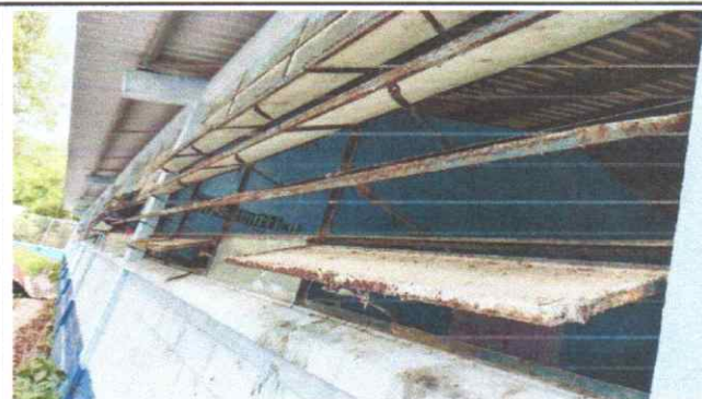
FOTO 2. SUSTITUCION DE BALCONES DE METAL
