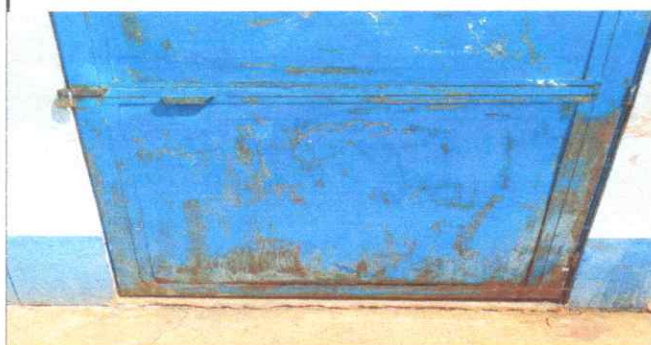
FOTO 1. MANTENIMIENTO A ESTRUCTURA (lijado, cambio de tubo, sellado, sujecion, aplicación de pintura)
