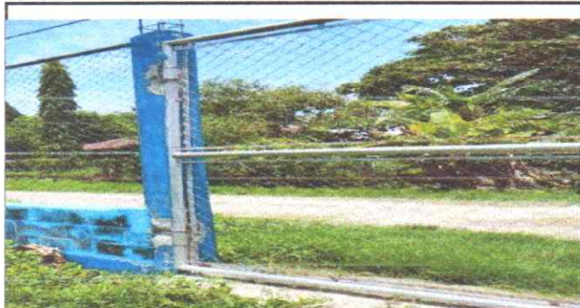
FOTO 5. MANTENIMIENTO A PORTON DE METAL
