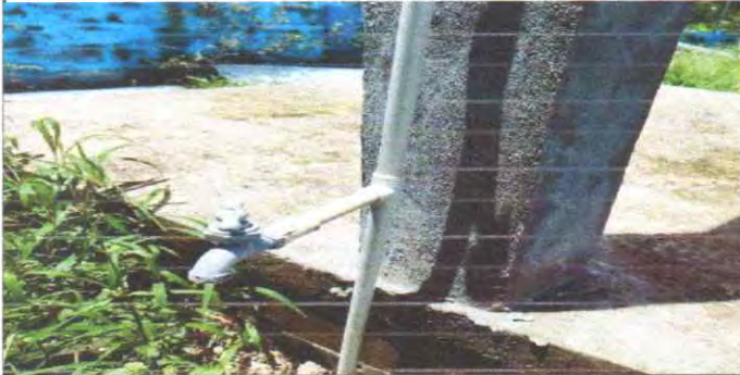
FOTO 7. SUSTITUCION DE TUBERIA LINEA PRINCIPAL
