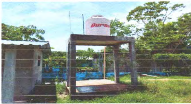
FOTO 9. SUSTITUCION DE DEPÓSITO DE AGUA DE 1,700 LITROS
