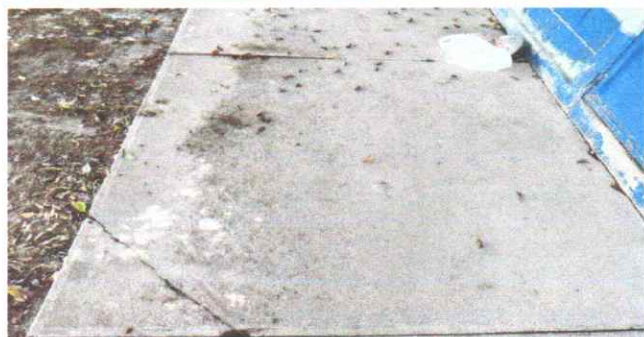
FOTO 3. SUSTITUCION DE PISO DE TORTA DE CONCRETO
