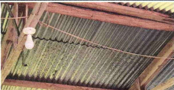
FOTO 6. SUSTITUCION DE FOCOS AHORRADORES
