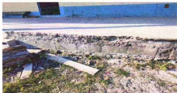
FOTO 3. REPARACION DE MURO DE CONTENCIÓN
