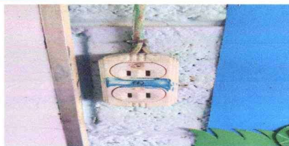
FOTO 8 SUSTITUCION DE TOMACORRIENTES DOBLE
