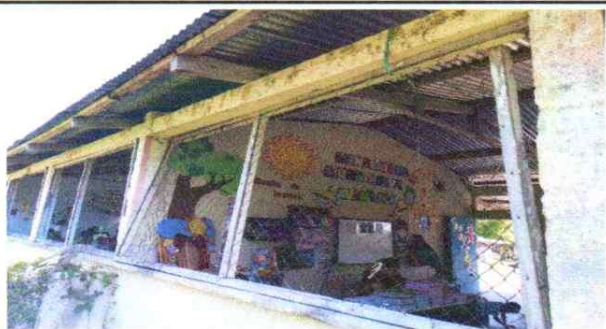
FOTO 7. SUSTITUCION DE BALCON DE METAL
