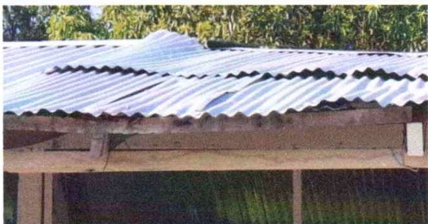
FOTO 1. SUSTITUCION DE LAMINA, POR LAMINA TROQUELADA ALUZING CALIBRE 26
