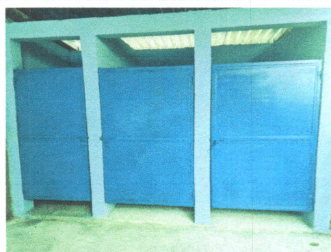
Foto 4: Sustitución de puertas en servicios sanitarios
