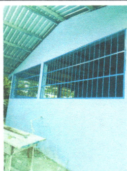
Foto 19: Fabricación e instalación de balcones de metal
