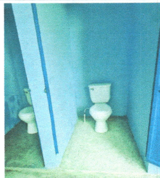
Foto 10: Instalacion de inodoros (incluye contrallave y accesorios)
