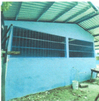
Foto 9: Pintura en muros exteriores e interiores
