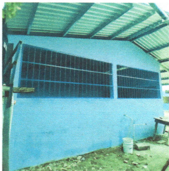
Foto 9: Pintura en muros exteriores e interiores
