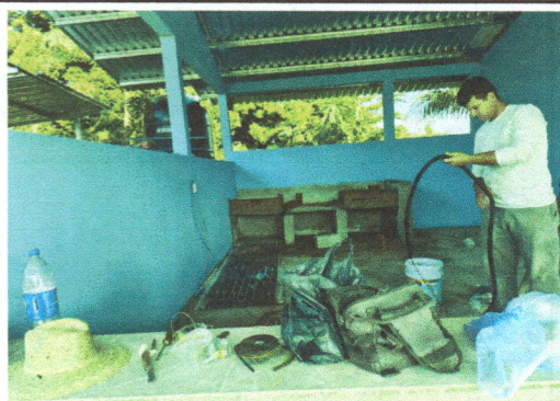
Foto 17: Reparación de sistema eléctrico
