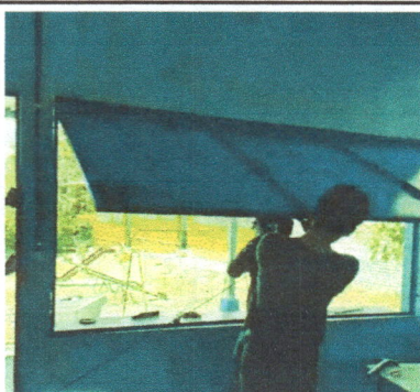
Foto 5: Sustitución de ventana de metal
