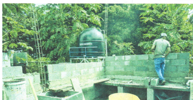
Foto 21: Reparación en muros y cernido de paredes, (levantado de block)
