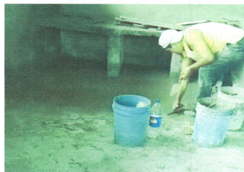
Foto 6: Sustitución de piso de torta de concreto
