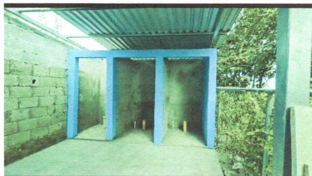
Foto 4: Sustitución de puertas en servicios sanitarios
