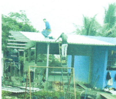
Foto 1: Sustitución de lámina, por lámina troquelada aluzinc calibre 26
