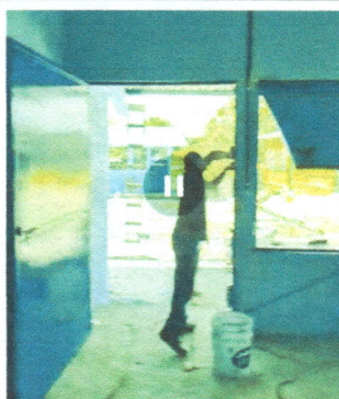
Foto 3: Sustitución de puertas
