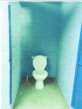
Foto 10: Instalación de inodoros (incluye contrallave y accesorios)
