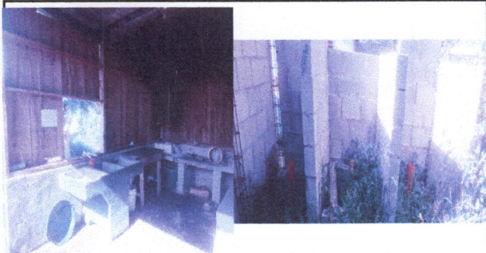
Foto 9: Pintura en muros exteriores e interiores
