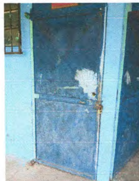
Foto 4: Sustrucción de puertas
