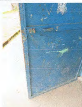
Foto 3: Sustrucción de puertas
