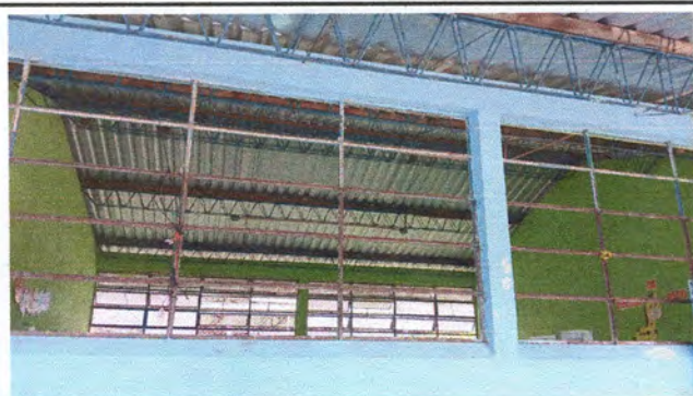
Foto 5: Sustrucción de balcones de metal
