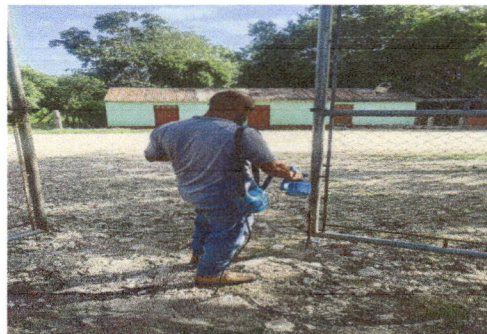
Foto 2: Mantenimiento a porton de metal
