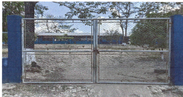
Foto 2: Mantenimiento a porton de metal
