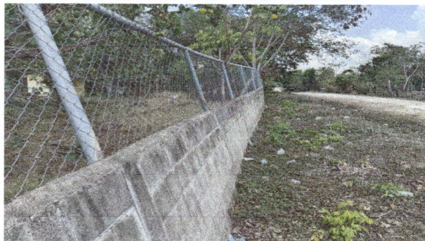
Foto1: Reparación de muro perimetral de block con tubo hg y malla galvanizada, soleras intermedias y columnas
