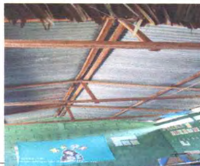
Foto 2: Mantenimiento a estructura de soporte de metal
