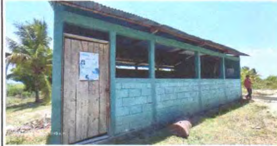
Foto 2: Instalación de planchas de concreto de patio
