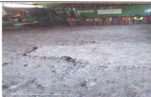
Foto 5: Sustrucción de piso torta de concreto
