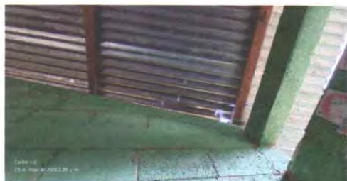
Foto 1: Sustrucción de lámina, por lámina troquedala alizinc calibre 26
