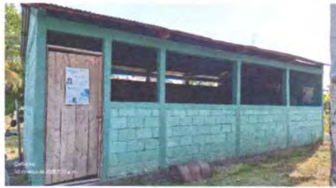
Foto 3: Pintura en muros exteriores e interiores
