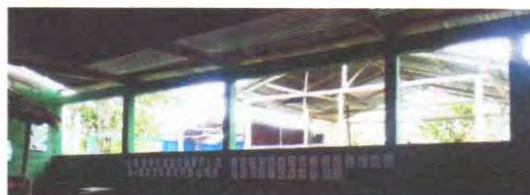
Foto 4: Instalación de marcos mill finish
