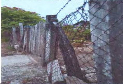
Foto 1: Instalación de tubo HG y malla galvanizada mas porton
