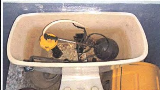
Foto 6: SUSTITUCION DE ACCESORIOS DE INODORO (CONTRA LLAVE, TUBO DE ABASTO Y TANQUE )
