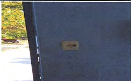
Foto 15: SUSTITUCIÓN DE INTERRUPTORES SIMPLE
