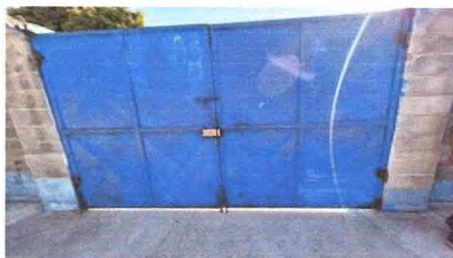
Foto 11: MANTENIMIENTO A PORTONES DE METAL
