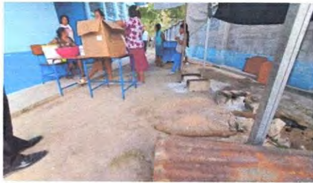
Foto 5: SUSTITUCIÓN DE PISO DE TORTA DE CONCRETO
