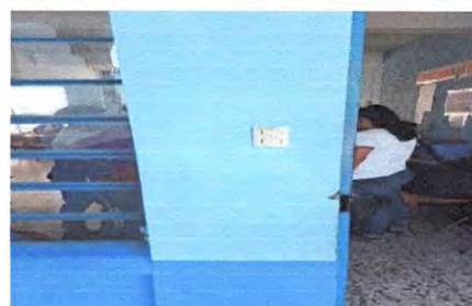
Foto 16: SUSTITUCIÓN DE INTERRUPTORES DOBLES
