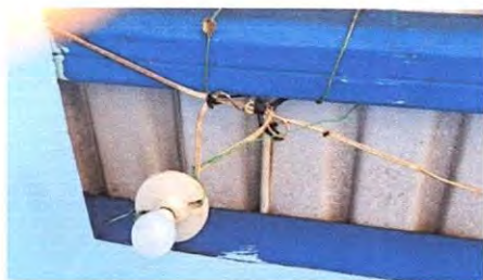
Foto 17: REPARACIÓN DE CABLEADO ELECTRICO
