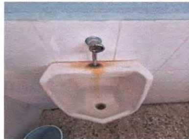
Foto 8: SUSTITUCIÓN DE LLAVE EN MIGITORIOS
