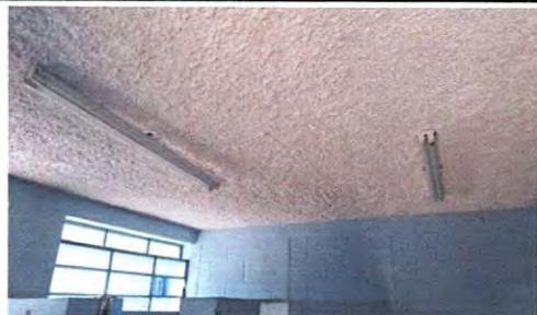
Foto 13: SUSTITUCIÓN DE FOCOS AHORRADORES
