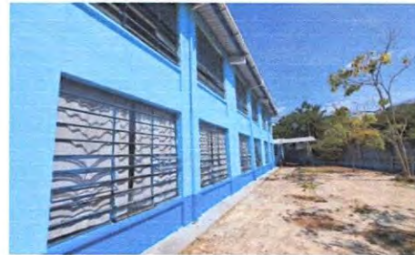
Foto 4: MANTENIMIENTO A BALCONES DE METAL
