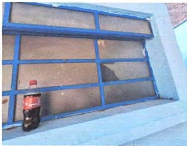
Foto 3: SUSTITUCION DE VIDRIOS
