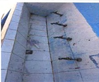
Foto 9: SUSTITUCIÓN DE GRIFOS
