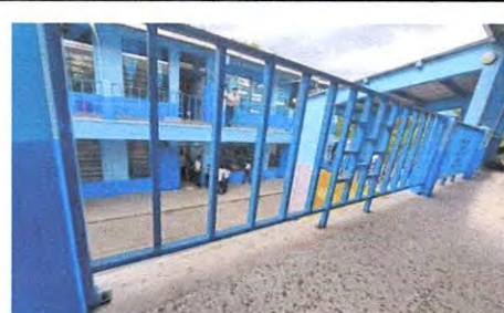
Foto 10: SUSTITUCIÓN DE BARANDAS DE METAL
