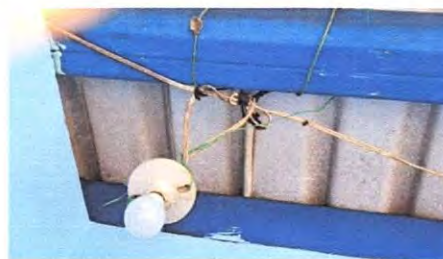
Foto 14: SUSTITUCIÓN DE PLAFONERAS
