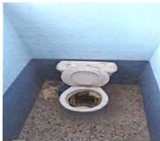
Foto 7: SUSTITUCIÓN DE INODOROS
