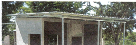
Foto 1: Sustitución de lámina, por lámina troquedala alizinc calibre 26
