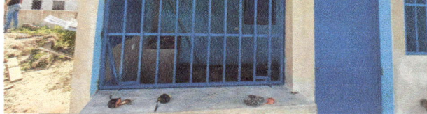
Foto 15. Fabricación e instalación de balcon de metal.
