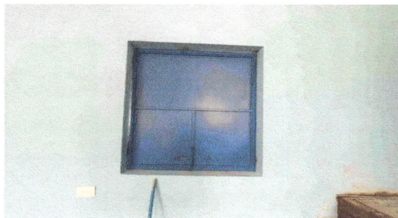
Foto 5: sustitución de Ventanas de Metal
