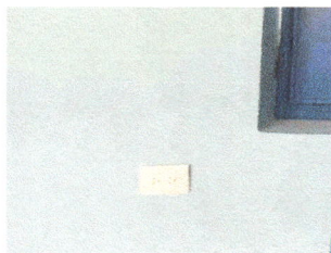
Foto 11: Sustitución de Tomacorrientes
