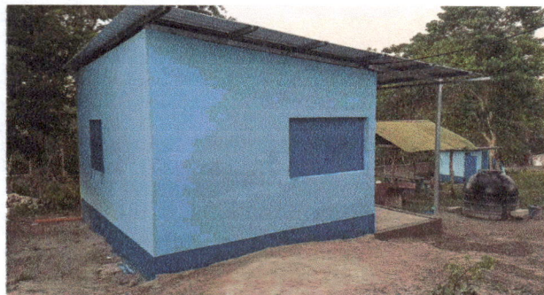
Foto 7: Pintura en muros exteriores e interiores
