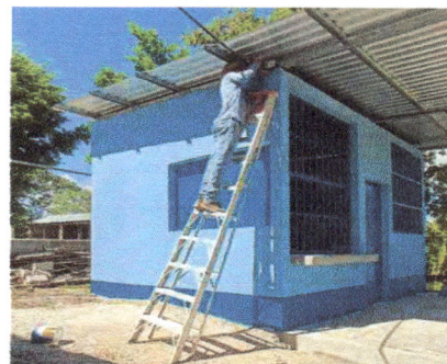
Foto 12: Reparación de Cableado Eléctrico
