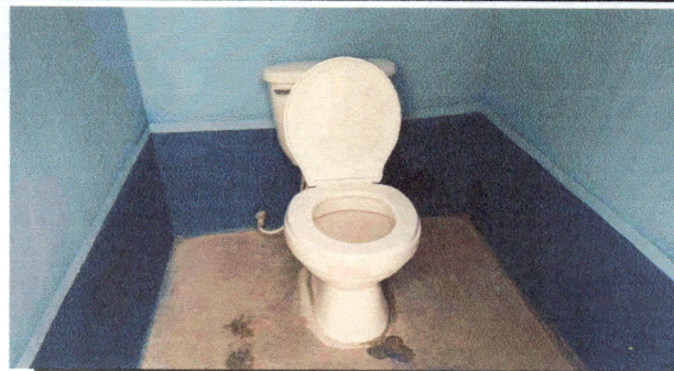
Foto 8: Instalación de inodoro
