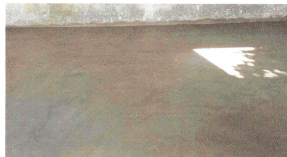
Foto 6: Sustitucion de piso de torta de concreto
