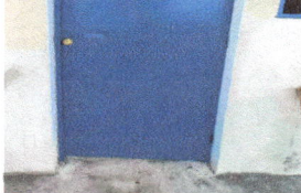
Foto 3: Sustitución de Puerta
