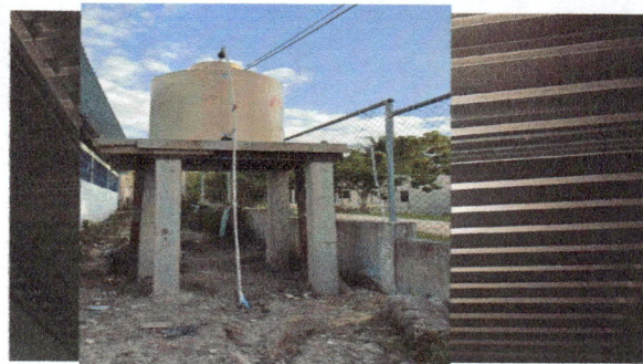
Foto 14: Sustitución de deposito de agua (accesorios e instalación)
