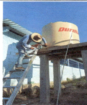
Foto 14: Sustitución de deposito de agua (accesorios e instalación)
