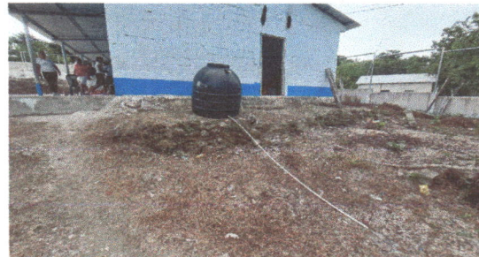
Foto 14: Sustitución de deposito de agua (accesorios e instalación)
