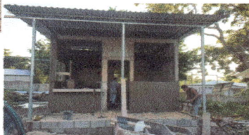
Foto 16. Reparacion en muros y cernidos de paredes (levantado de pared)
