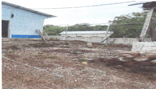
Foto 13: Sustitución de ducto Eléctrico + accesorios
