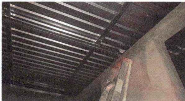
Foto 13: Sustitución de ducto Eléctrico + accesorios
