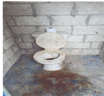
Foto 8: Instalación de inodoro
