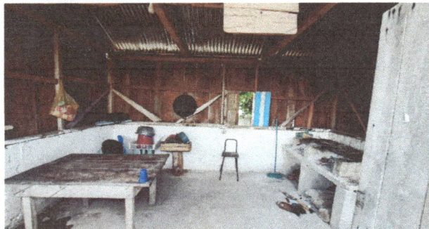
Foto 5: sustitución de Ventanas de Metal
