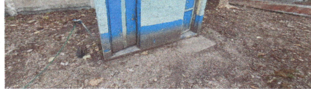
Foto 4: Instalación de puertas en servicio sanitario
