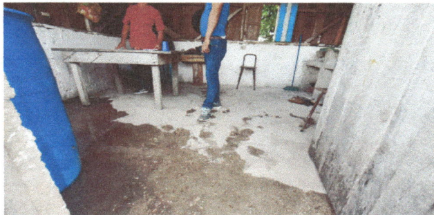
Foto 6: Sustitucion de piso de torta de concreto
