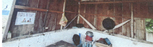
Foto 10: Sustitución de Plafoneras
