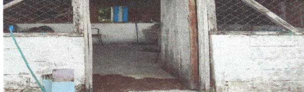
Foto 3: Sustrucción de Puerta
