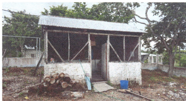
Foto 7: Pintura en muros exteriores e interiores
