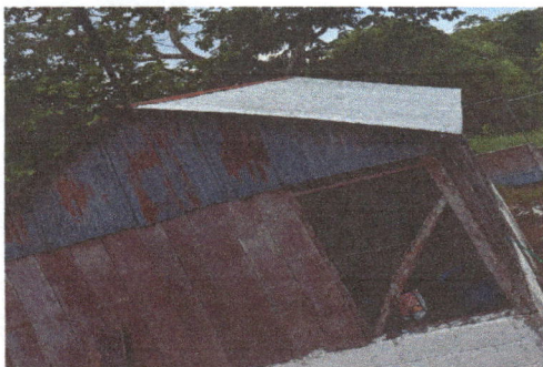
Foto 1: Sustitución de lámina, por lámina troquedala alizinc calibre 26
