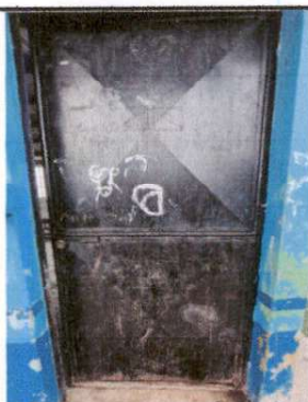
Foto 3: SUSTITUCIÓN DE PUERTAS
