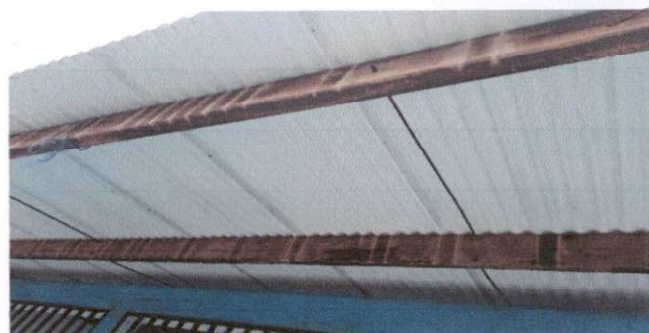
Foto 2: MANTENIMIENTO A ESTRUCTURA DE SOPORTE DE METAL
