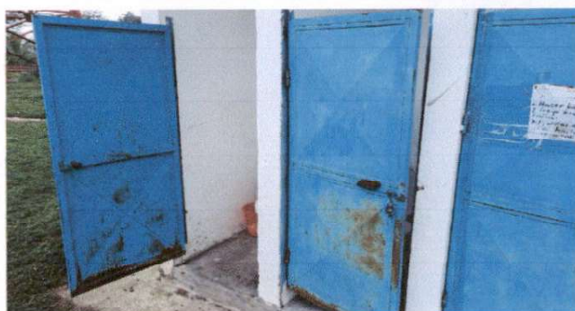
Foto 4: PINTURA A PUERTAS SERVICIOS SANITARIOS
