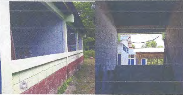
Foto 9: Repello en Muros (Sellado de ventana, con block, atrás de la Dirección)
