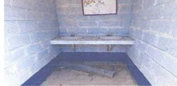
Foto 8: Pintura en muros exteriores e interiores
