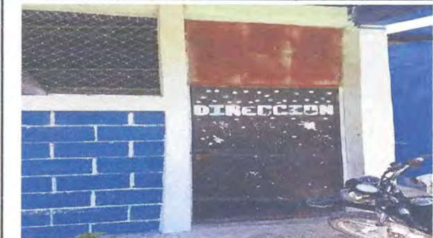
Foto 3: Matenimiento a estructura (lijado, cambio de tubo, cepillado, sujeciones, aplicación de pintura)
