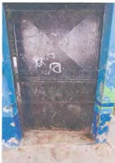
Foto 5: sustitución de Puerta
