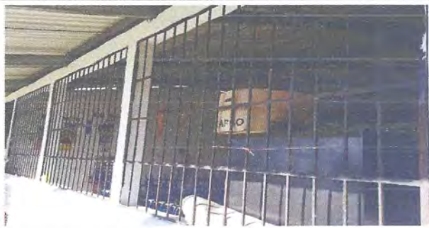
Foto 6: Mantenimiento a balcones de metal
