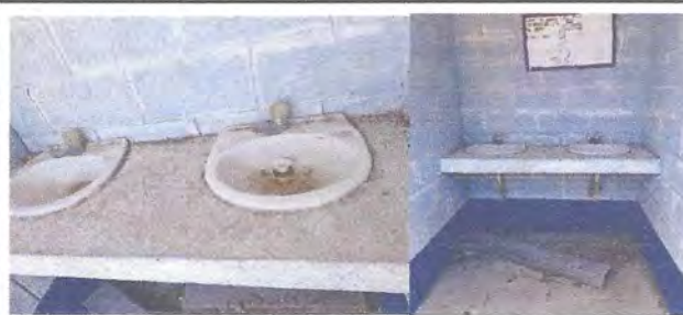
Foto 10: Mantenimiento de lavamanos
