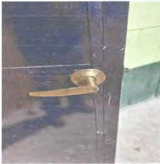
Foto 4: Sustitución de Chapa
