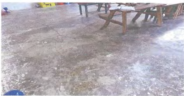
Foto 7: Instalación de piso Cerámico
