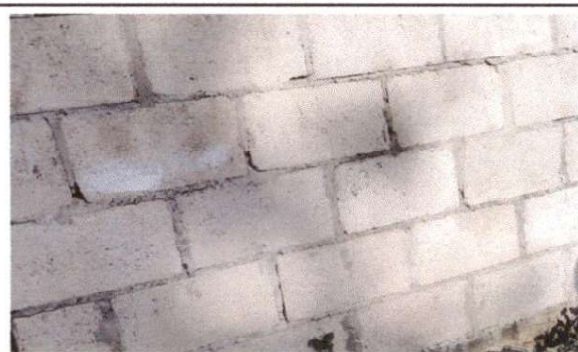
FOTO No.4 PINTURA EN EXTERIOR
