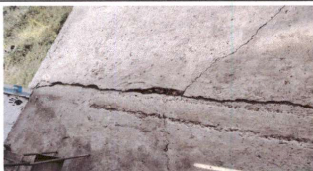
FOTO No. 1 SUSTITUCION DE PISO DE TORTA DE CONCRETO
