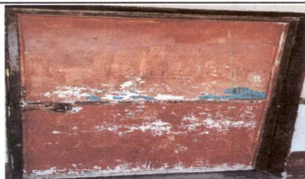
FOTO No. 3 SUSTITUCION DE PUERTAS
