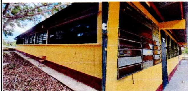
Foto 4: Sustrucción de balcones de metal
