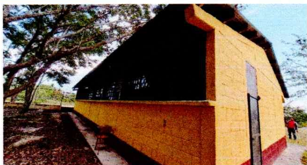
Foto 5: Pintura en muros exteriores e interiores
