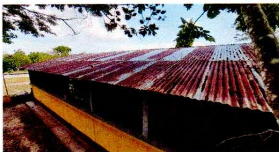
Foto 1: Sustrucción de lámina, por lámina troquedala alizinc calibre 26
