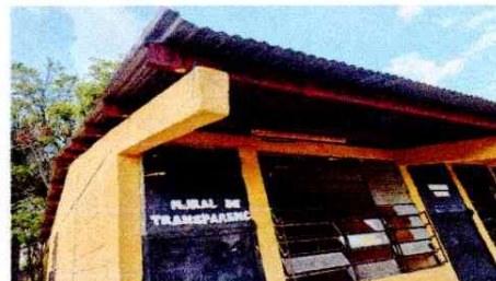
Foto 2: Mantenimiento a estructura de soporte de metal
