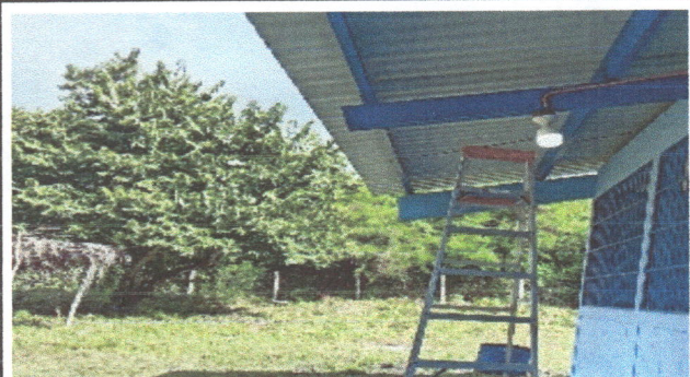
foto 9. sustitucion de plafonera
