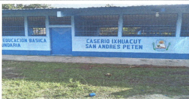
foto 5, pintura en muros exteriores e interiores
