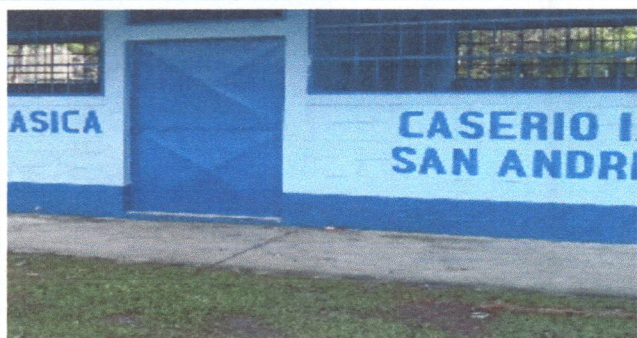
foto 1. mantenimiento a estructura (lijada, cepillada y aplicación de pintura)
