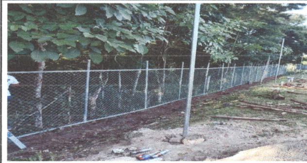
foto 6. reparacion de tubo HG y malla galvanizada
