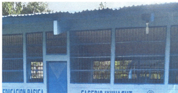
fot 3. mantenimiento a balcones de metal
