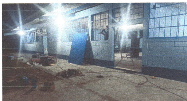
foto 8. sustitucion de focos ahorradores
