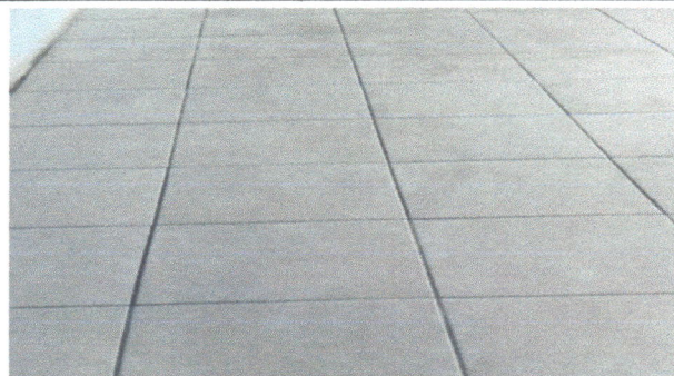
FOTO 4 SUSTITUCIÓN DE PISO DE CERAMICA
