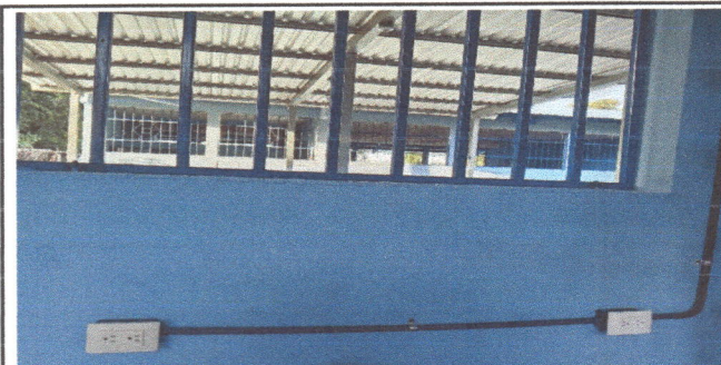
foto 11. sustitucion de tomacorrientes dobles
