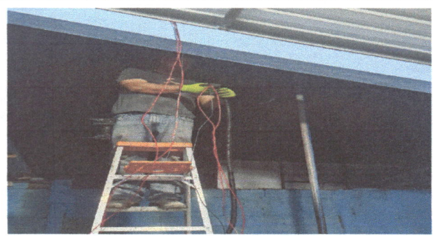
Foto 8: Reparación de cableado Eléctrico
