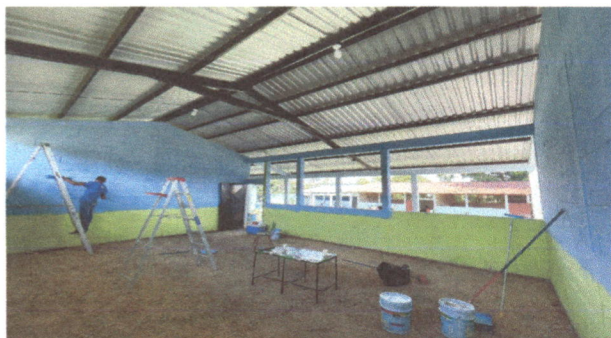
Foto 3: Pintura en muros exteriores e interiores
