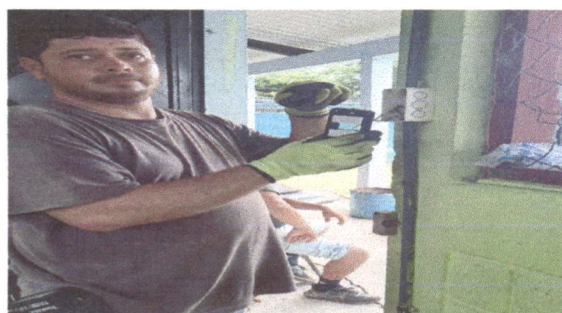
Foto 6: Sustitución de Interruptores Dobles
