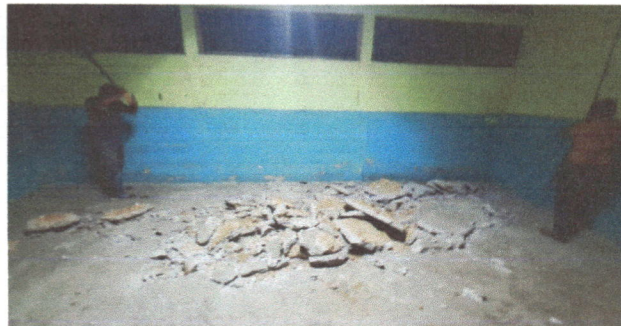
Foto 2: Sustitución piso torta de concreto
