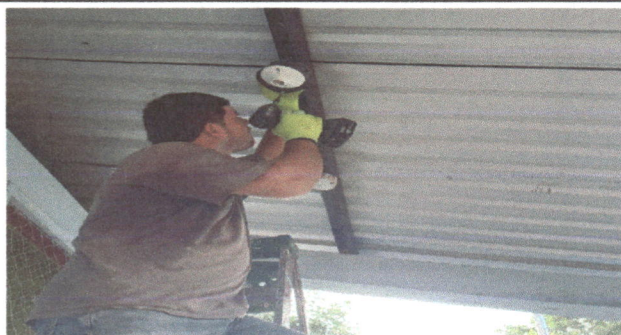
Foto 5: Sustitución de plafoneras
