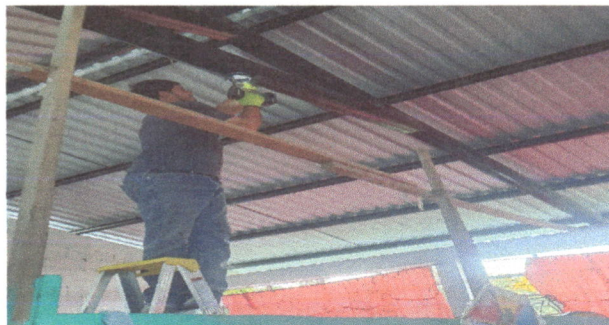
Foto 4: Sustitución de Focos ahorradores
