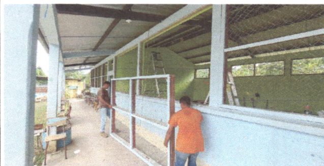
Foto 1: Sustitución de Balcones de metal
