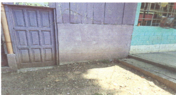
Foto 9: Sustitución de Ducto Eléctrico + Accesorios
