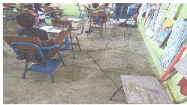
Foto 2: Sustitución piso torta de concreto
