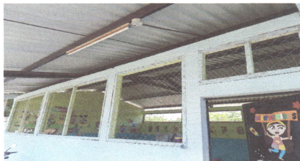
Foto 5: Sustitución de plafoneras
