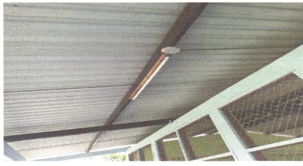
Foto 4: Sustitución de Focos ahorradores
