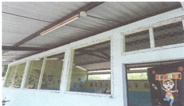
Foto 1: Sustitución de Balcones de metal
