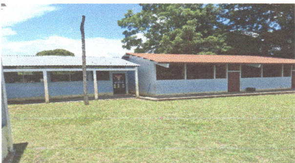
Foto 3: Pintura en muros exteriores e interiores
