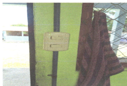
Foto 6: Sustitución de Interruptores Dobles
