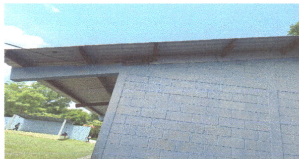
Foto 8: Reparación de cableado Eléctrico
