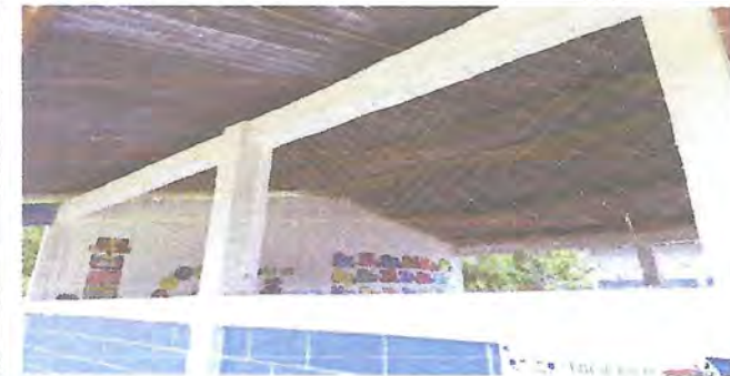
Foto 4: Sustitución de Balcones
