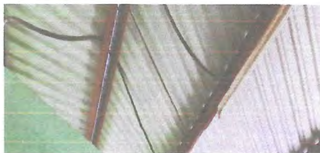
Foto 12: Sustitución de ducto eléctrico + accesorios
