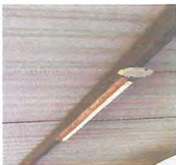
Foto 9: Sustitución de focos ahorradores
