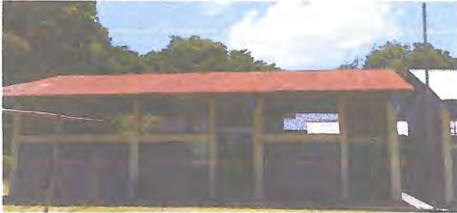
Foto 1: Sustitución de lámina, por lámina troquedala alizinc calibre 26
