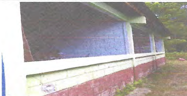
Foto 8: Repello en Muros (Sellado de ventana, con block, atrás de la Dirección)
