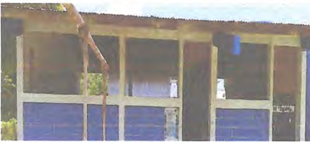
Foto 3: Fabricación e instalación a marcos de aluminio mil finish
