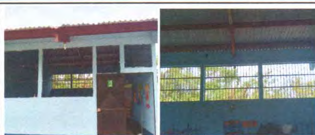
Foto 2: Mejoramiento de ventanas en dos aulas de aluminio mill finish (Percianas)
