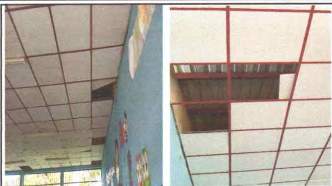
Foto1: Sustitución de cielo falso de dos aulas por cielo falso pvc
