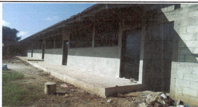
Foto 3: En esta imagen se observa que las cuatro aulas ya estan listas con sus puertas y sus balcones asi como tambien cada una tiene el piso liso de cemento.
