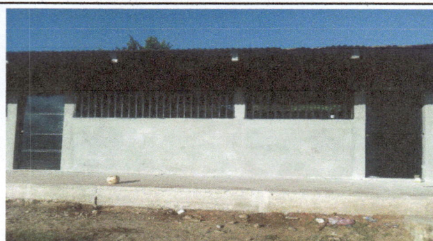
Foto 2: En esta imagen se detalla los balcones de metal y las puertas de metal.
