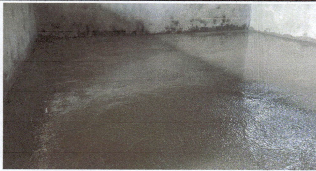
Foto 1: En esta imagen se observa que se esta trabajando en el piso de las aulas que se priorizaron.
