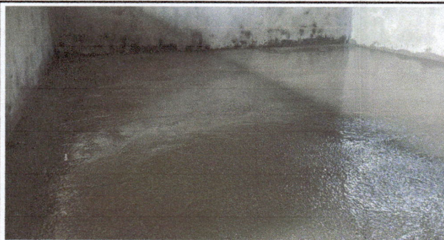
Foto 1: En esta imagen se observa que se esta trabajando en el piso de las aulas que se preorizaron.
