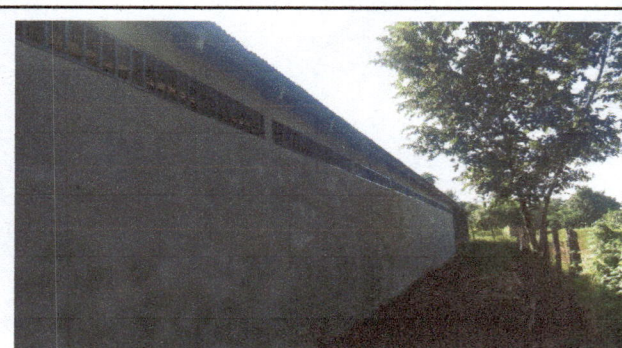
Foto 4: En esta imagen se observa que los balcones de la parte de atrás ya estan listos.
