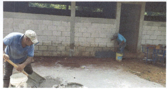
Foto 2: Se observa que los padres realizan la mezcla para poder repellar y terminar el piso de las aulas.
