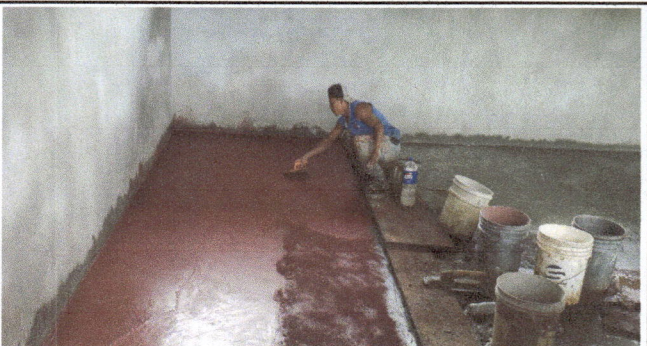
Foto 4: En esta imagen se observa como se está colocando un material para el piso de cemento liso con color.
