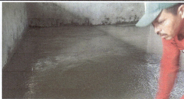
Foto 3: Se observa como el padre de familia que es albañil está en proceso de culminación del piso.
