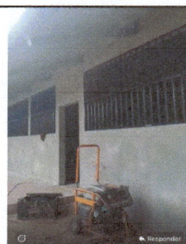
Foto 6: Esta imagen muestra como están trabajando en colocar los balcones en la parte de enfrente de las aulas.
