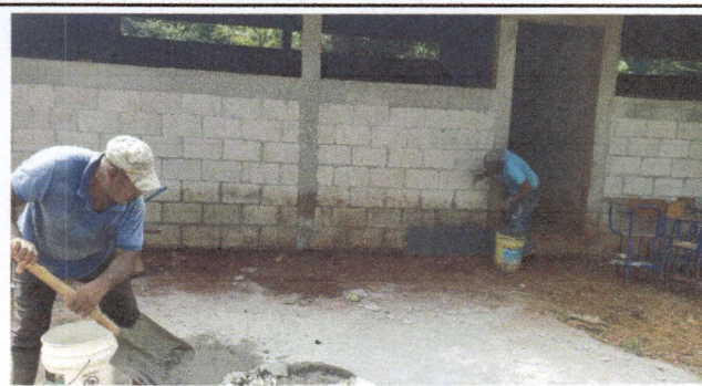
Foto 2: Se observa que los padres realizan la mezcla para poder repellar y terminar el piso de las aulas.
