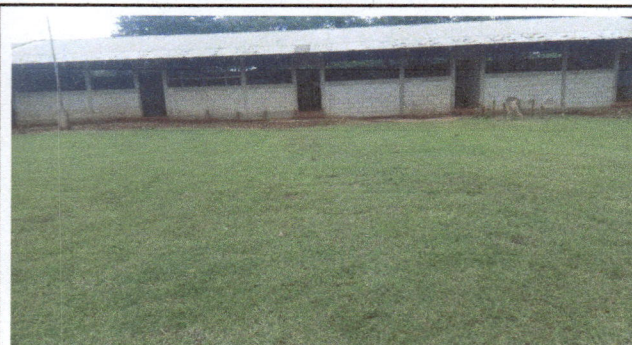
Foto 2: Sustitución de puertas de metal
