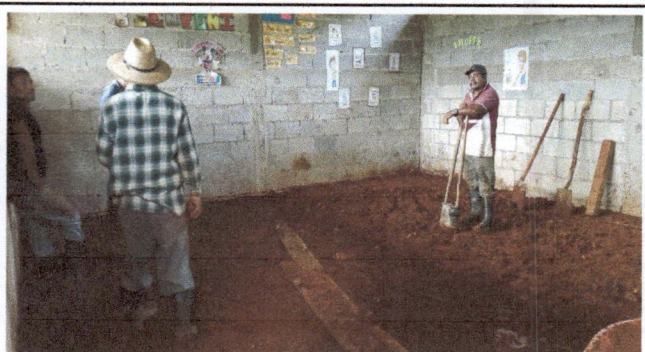
Foto 3: Sustitución de piso de cemento liso
