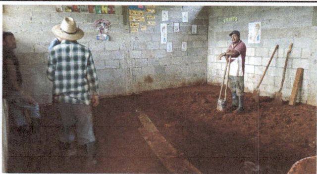
Foto 3: Sustitución de piso de cemento liso
