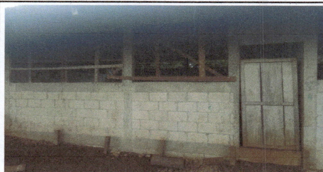
Foto 1: Sustitución de balcones de metal,
