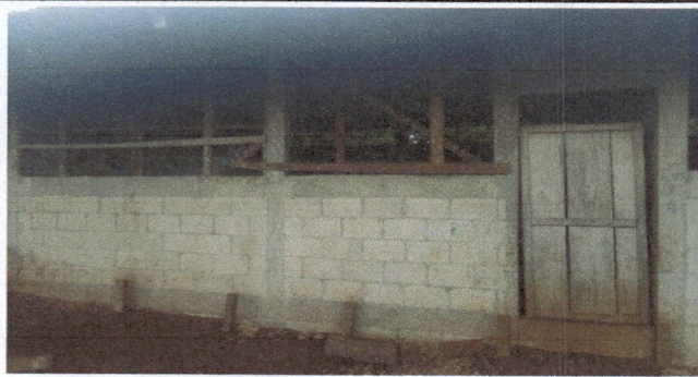
Foto 1: Sustitución de balcones de metal,
