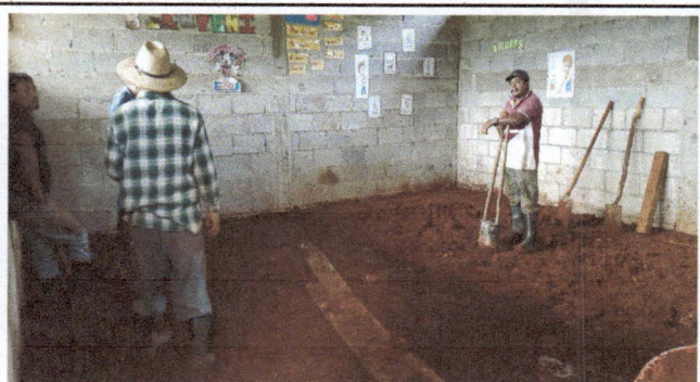
Foto 3: Sustitución de piso de cemento liso
