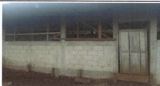
Foto 1: Sustitución de balcones de metal,
