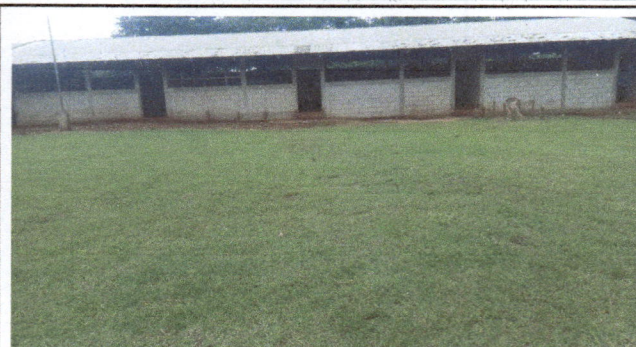
Foto 2: Sustitución de puertas de metal
