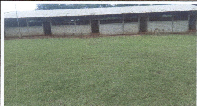
Foto 2: Sustitución de puertas de metal
