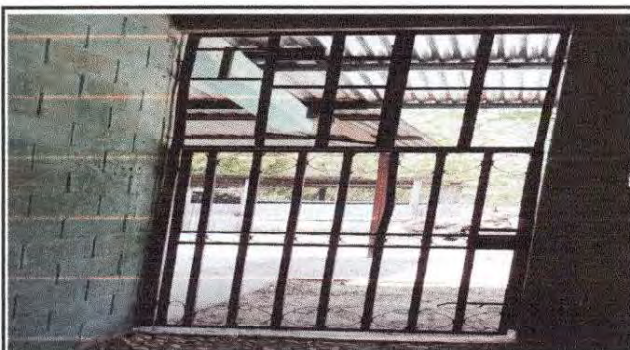
Foto 3: Fabricación e instalación de puerta de metal
