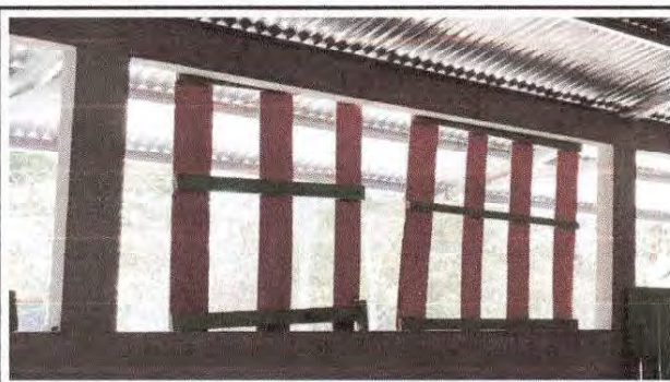
Foto 4: Fabricación e instalación de ventana-balcon de metal
