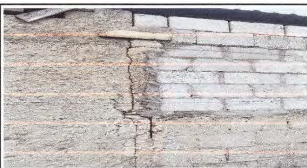
Foto 4: Repello en muro
