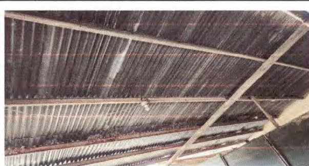
Foto 2: Instalación de estructura portante de metal
