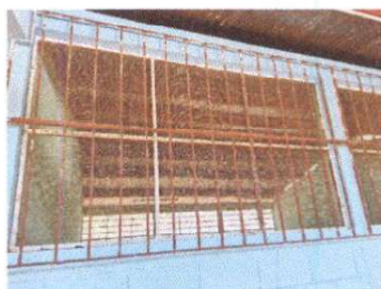
Sustitución de balcones de metal
