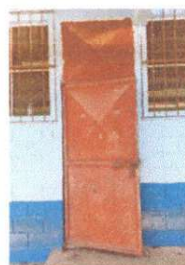
Sustitución de puerta
