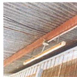
Instalación de unidades luz (incluye interruptor, ducto y cableado)
