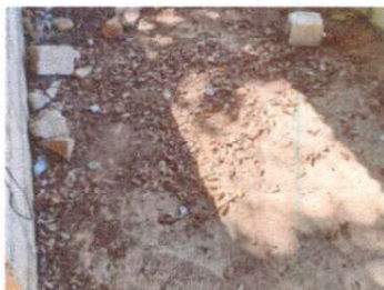
Sustitución de piso de torta de concreto
