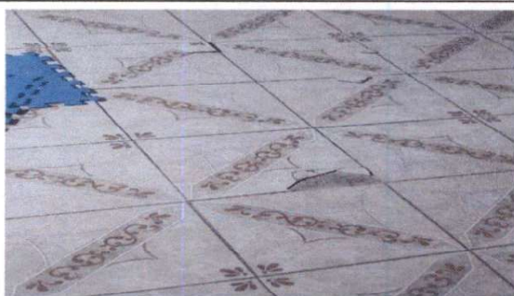
Sustitución de piso ceramico
