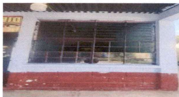
Pintura en muros exterior e interior
