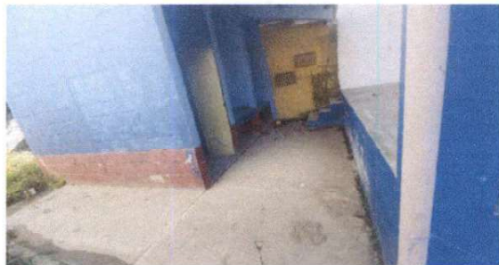
Sustitución de piso de torta de concreto
