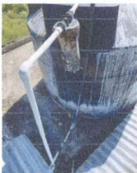
Foto 13: Sustitución de accesorios depósito de agua
