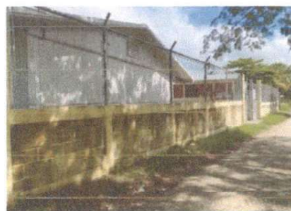
Foto 10: Pintura en muros exteriores e interiores
