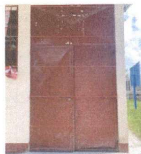
Foto 12: Mantenimiento a estructura (lijado, cambio de tubo, cepillado, sujeciones, aplicación de pintura)
