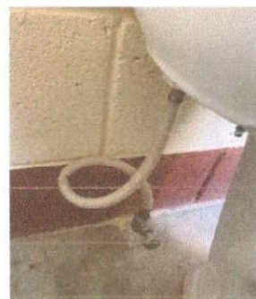
Foto 8: Sustrucción de accesorios inodoro (contra llave, tubo de abasto y tanque)
