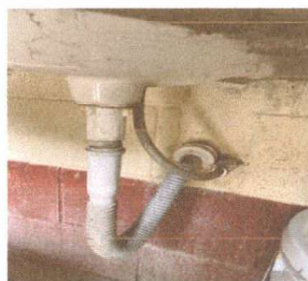
Foto 6: Sustrucción de mezcladora lavamanos (contra llave, tubo de abasto).
