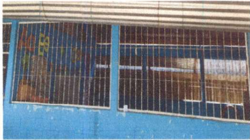
Foto 7: Sustitución de balcones de metal
