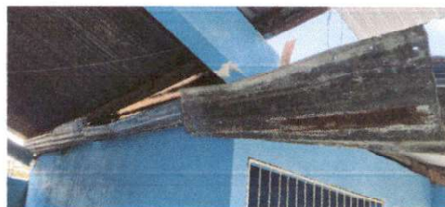
Foto 6: Sustitución de canal de metal
