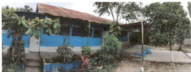
Foto 1: Sustitución de lámina por lámina troquelada aluzinc calibre 26
