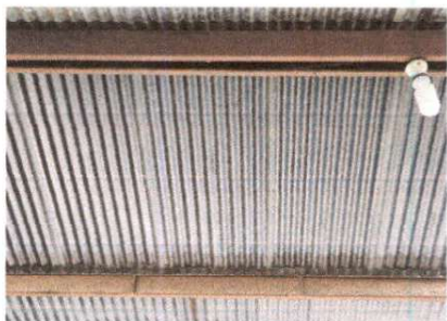
Foto 5: Mantenimiento a estructura de soporte de metal
