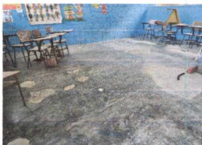
Foto 3: Sustitución de piso de torta de concreto
