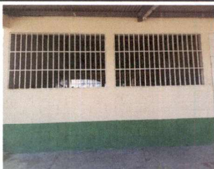
Foto 3: MANTENIMIENTO DE ESTRUCTURA DE METAL DE VENTANA
