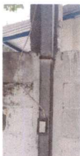
Foto 9: SUSTITUCION DE DUCTO ELECTRICO MAS ACCESORIOS
