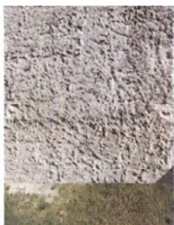
Foto 7: REPELLO EN MUROS
