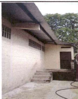
Foto1: SUSTITUCION DE LAMINA, POR LAMINA TROQUELADA ALUZINC CALIBRE 26
