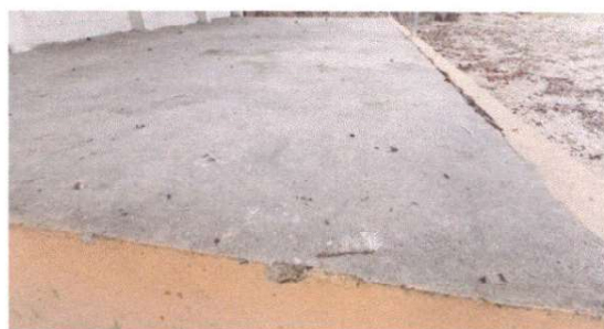
Foto 6: SUSTITUCIÓN DE PISO DE TORTA DE CONCRETO
