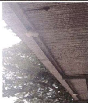
Foto 8: SUSTITUCION DE LAMPARA 2X40
