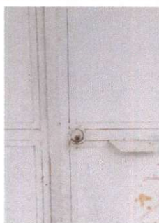
Foto 5: SUSTITUCION DE CHAPA
