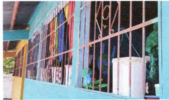
Foto 3: Mantenimiento a balcones
