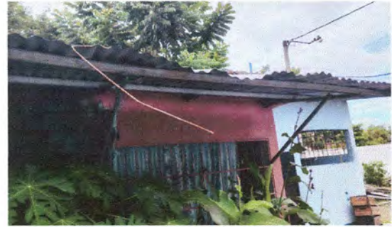
Foto 2: Sustrucion de estructura de soporte de metal
