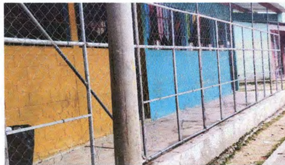
Foto 5: Sustrucion de baranda de metal
