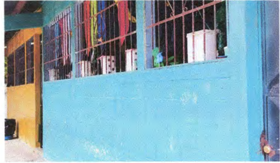
Foto 4: pintura en muros
