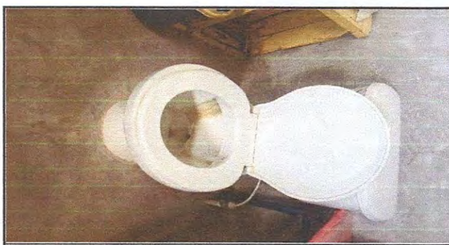
Foto 6: 10.3 SUSTITUCIÓN DE INODORO
