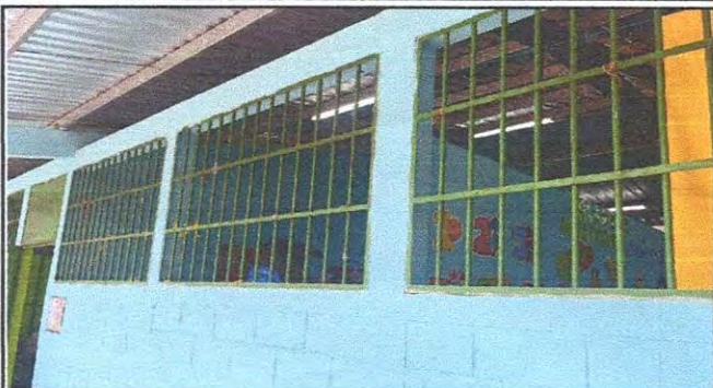
Foto 1: 5.7 MANTENIMIENTO A BALCONES DE METAL
