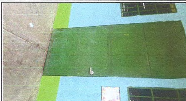
Foto 2: 4.1 MANTENIMIENTO A ESTRUCTURA (LIJADO, APLICACIÓN DE PINTURA)
