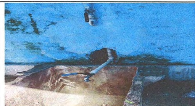
FOTO No 10 SUSTITUCION DE TUBERIA LINEA PRINCIPAL
