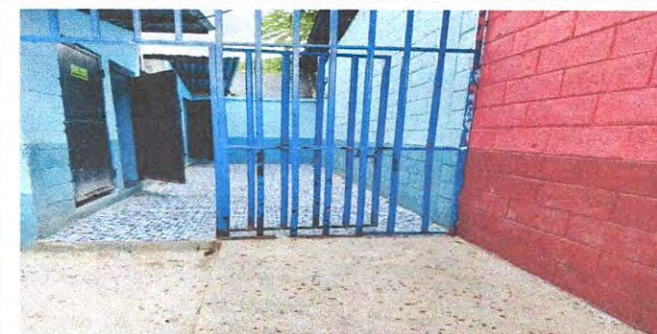
FOTO No 11 MANTENIMIENTO A PORTON DE METAL
