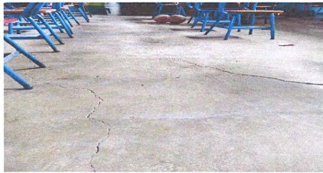
FOTO No 8 SUSTITUCION DE TORTA DE CEMENTO LIQUIDO POR PISO DE CERAMICO
