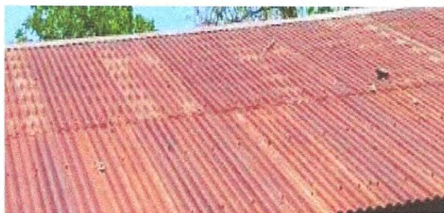
FOTO 3. SUSTITUCION DE UNIDADES DE FIJACION
