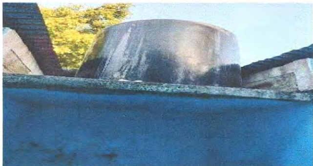
FOTO No 13 SUSTITUCION DE DEPOSITO DE AGUA DE 1,100 LITROS
