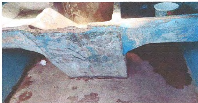
FOTO No, 13 SUSTITUCION DE CONCRETO DE 2 LAVADEROS
