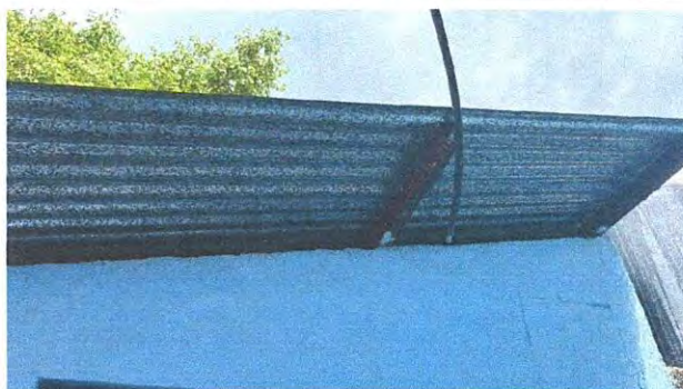
FOTO 5. SUSTITUCION DE ESTRUCTURA DE SOPORTE DE METAL, POR METAL
