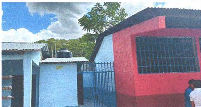
FOTO 1. SUSTITUCION DE LAMINA, POR LAMINA TROQUELAD ALIZINC CALIBRE 26
