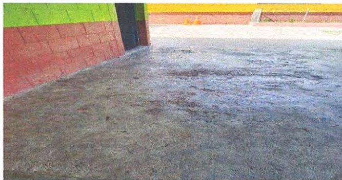
FOTO No 7. SUSTITUCION DE TORTA DE CONCRETO
