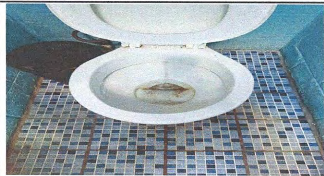
FOTO No 9 SUSTITUCION DE INODOROS
