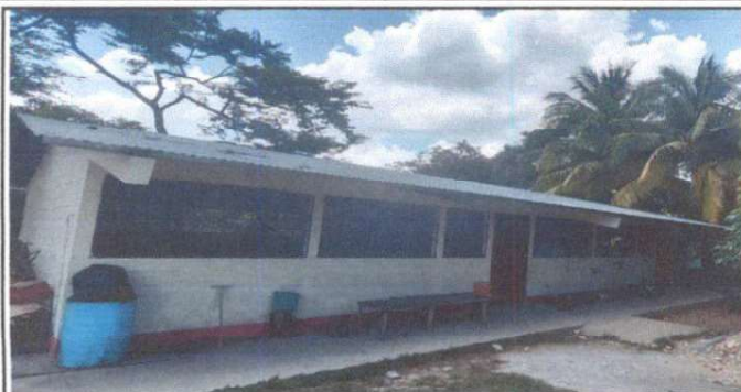
Foto1: Pintura interior y exterior
