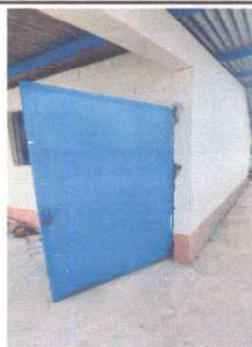
Foto 3: Sustitución de chapas
