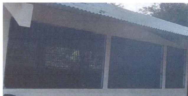
Foto 4: Mantenimiento de Balcones de metal
