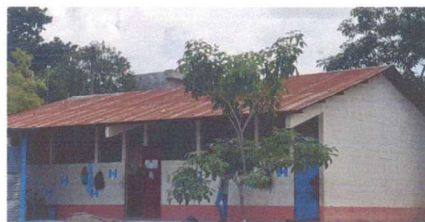
Foto 6: Sustitución de lamina
