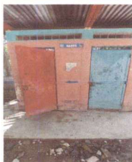
Foto 5: Sustitución de puertas de baño
