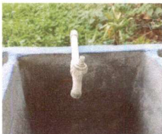
Sustitución de llave de chorro
