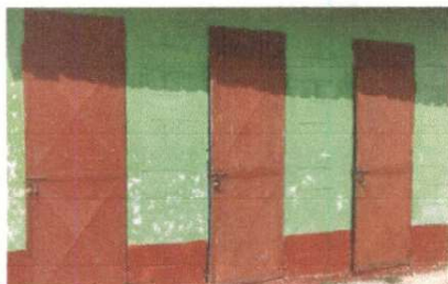
Sustitución de puerta
