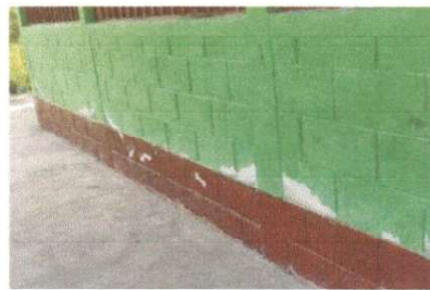
Pintura en muros exteriores e interiores
