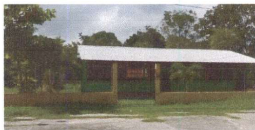
Reparación de tubo hg y malla galvanizada
