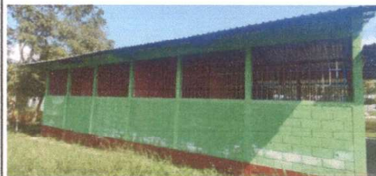
Mantenimiento a balcones de metal
