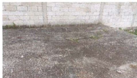
Reparación de piso de torta de concreto
