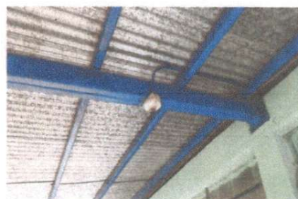
Instalación de unidades luz (incluye interruptor, ducto y cable eléctrico)
