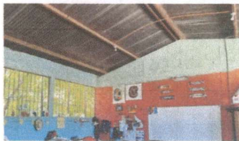
Mantenimiento a estructura de soporte de metal
