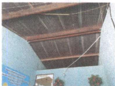
Sustitución de elementos de fijación
