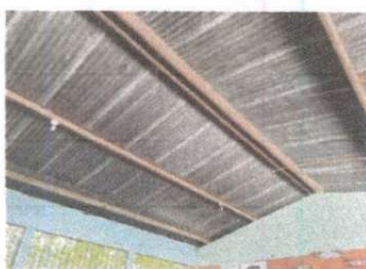
Instalación de lámina troquelada aluzinc
