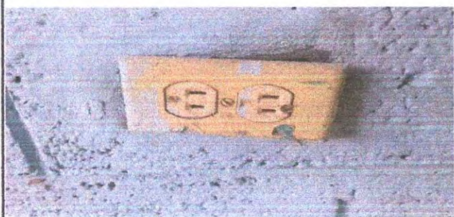
Foto 19: 17.8 Sustitución tomacorrientes dobles.
