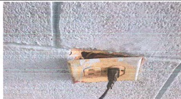
Foto 10: 17.8 Sustitución tomacorrientes dobles.
