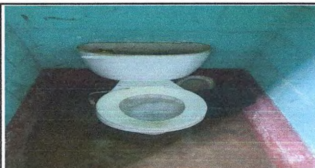
Foto 12: 10.3 Sustitución de inodoro.
