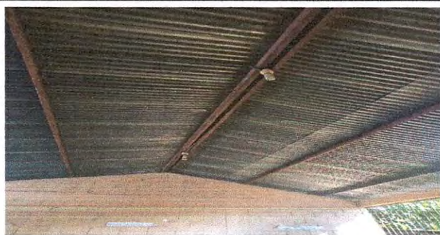
Foto 9: 17.4 Sustitución de focos ahorradores.
