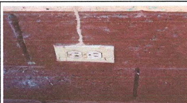
Foto8: 17.8 Sustitución tomacorrientes dobles.
