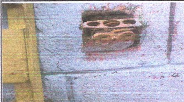
Foto 20: 17.8 Sustitución tomacorrientes dobles.
