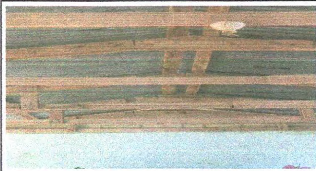
Foto1: 2.2Sustitución de estructura de soporte de madera, por metal.
