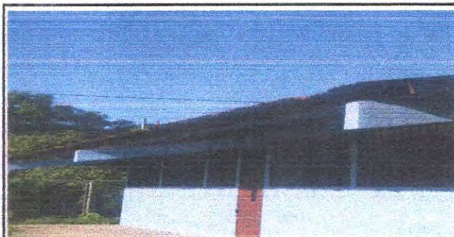
Foto 6: 1.1 sustitucion de lámina, por lámina troquelada aluzinc calibre 26
