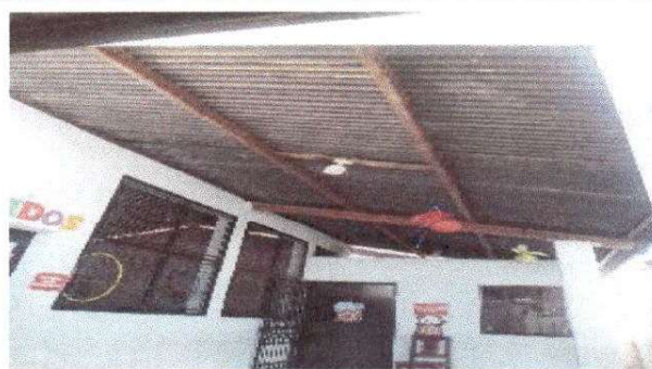
SUSTITUCION DE ESTRUCTURA DE SOPORTE DE METAL POR METAL
