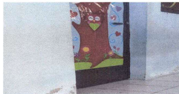
SUSTITUCION DE PUERTA
