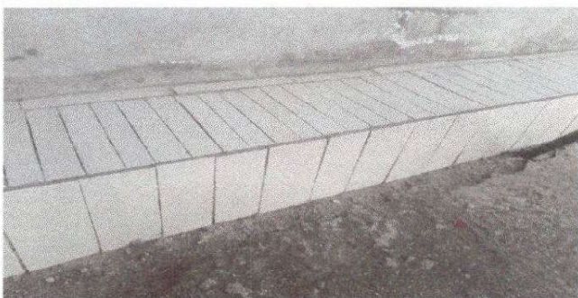
SUSTITUCION DE CERAMICO
