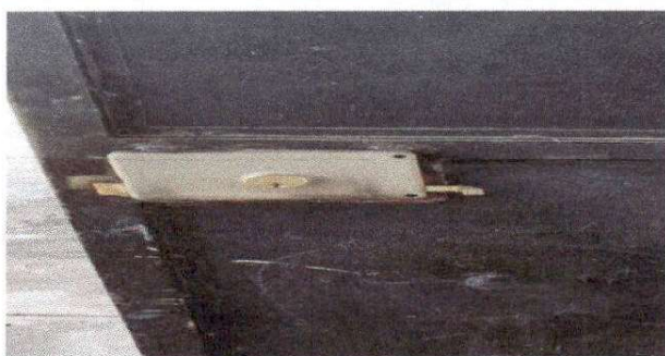
SUSTITUCION DE CHAPA
