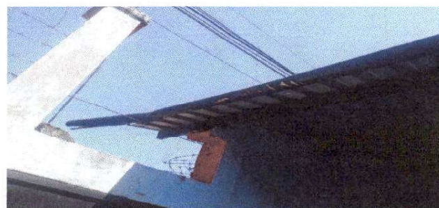
SUSTITUCION DE CANAL DE PVC
