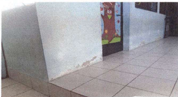
PINTURA EN MUROS INTERIOR EXTERIOR
