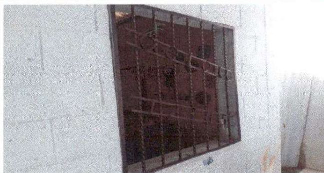
SUSTITUCION DE BLCON DE METAL
