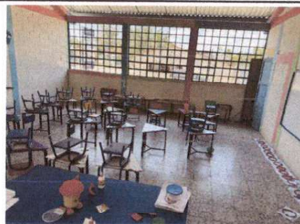
Foto 6: sustitución de piso de granito
