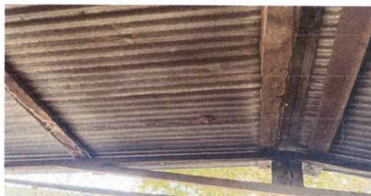
Foto 2: SUSTITUCION DE SOPORTE DE MADERA POR METAL
