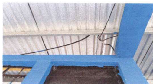
Foto 4: Sustitución de ducto eléctrico más accesorios
