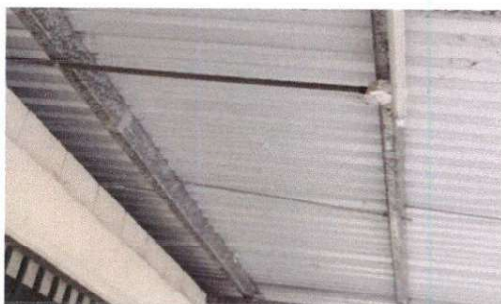
Foto 5: sustitución de lamparas Led
