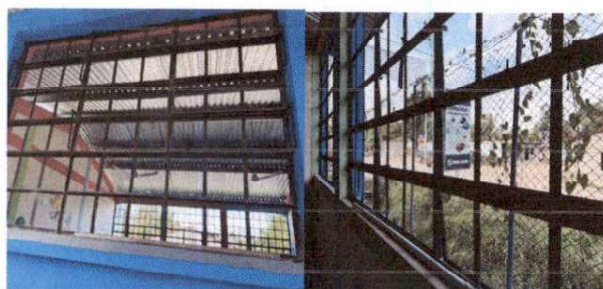
Foto 3: sustitución de vidrios
