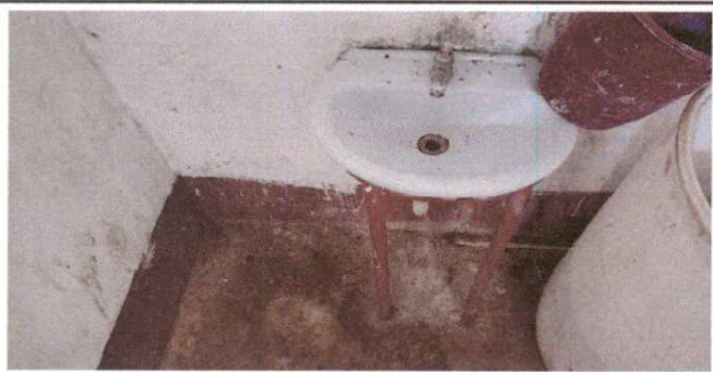
SUSTITUCION DE LAVAMANOS
