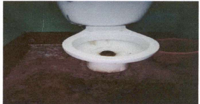
SUSTITUCION DE INODOROS
