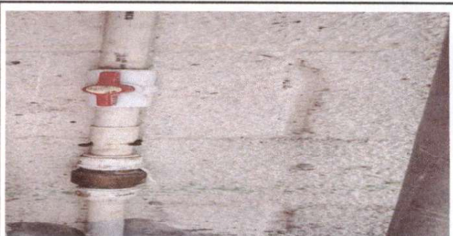
SUSTITUCIÓN DE LLAVE DE PASO
