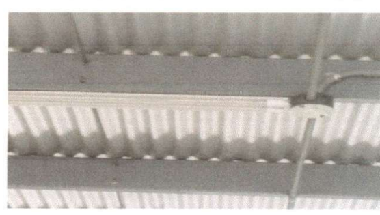
Foto 4: Sustrucción de ducto electrico mas accesorios
