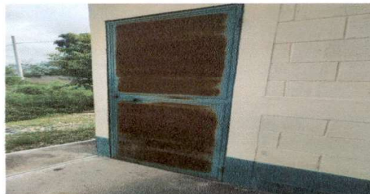
Foto 8: mantenimiento a estructura de puertas de metal
