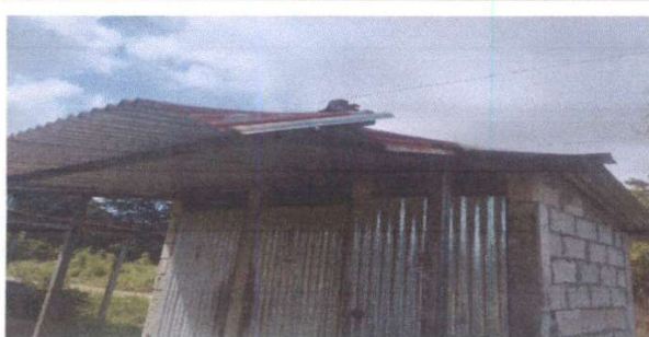
Foto 1: Sustrucción de lámina por lámina troquelada de aluzinc calibre 26
