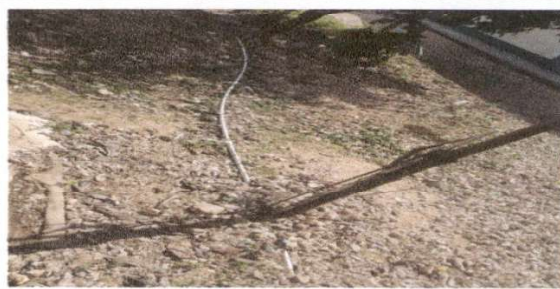
Foto 12: Sustitucion de tuberia linea principal de agua potable
