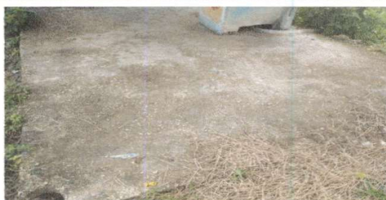
Foto 9: Reparacion de planchas de concreto de patio
