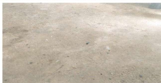
Foto 10. Reparación de piso de torta de concreto
