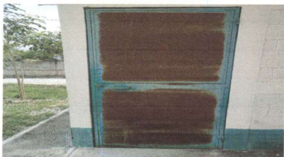
Foto7: Sustitución de puertas
