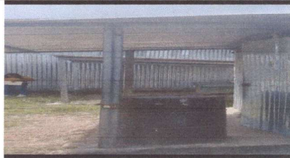
Foto 2: Sustruccuo de estructura de soporte de metal por metal
