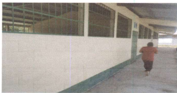
Foto 3: pintura en muros exteriores e interiores
