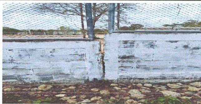
FOTO 6 REPARACION DE MURO PERIMETRAL DE BLOCC
