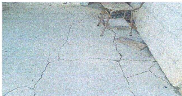
FOTO. 4 SUTITUCION DE TORTA DE CONCRETO
