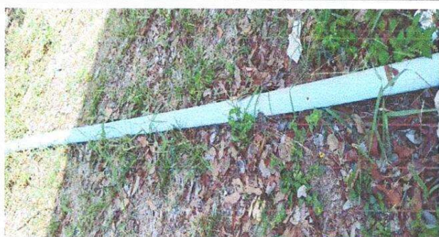
FOTO 5. SUSTITUCION DE TUBERIA DE PVC LINEA PRINCIPAL DE AGUAS NEGRAS
