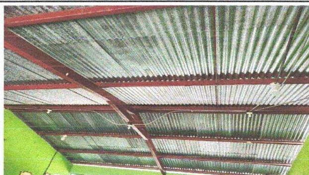
FOTO 2. MANTENIMIENTO A ESTRUCTURA PORTANTE DE METAL
