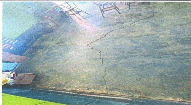
FOTO 4 SUSTITUCION DE PISO DE CEMENTO LIQUIDO
