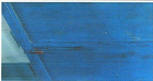
FOTO 5 SUSTITUCION DE CHAPAS
