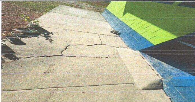
FOTO 6. SUSTITUCION DE PISO DE TORTA DE CONCRETO
